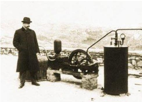
**Figura 3:** Larderello 1904. La prima macchina (un motore alternativo accoppiato ad una dinamo), che ha prodotto elettricità sfruttando il vapore geotermico. A fianco, il Principe Piero Ginori Conti, succeduto a Francesco Larderel nella proprietà dell'industria boracifera.
