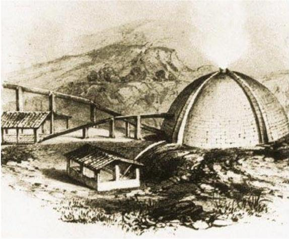
**Figura 2:** "Lagone coperto" a Larderello. All'interno di queste strutture in mattoni erano raccolte e fatte evaporare le acque boriche.
