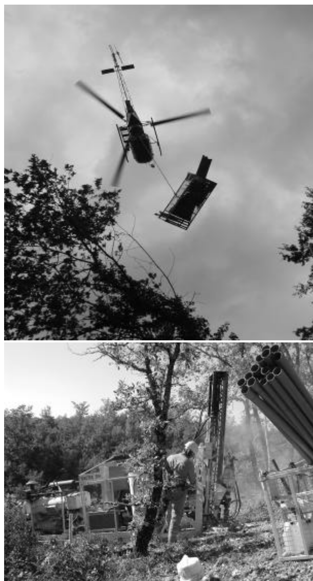
Figura 2 – Impianto di perforazione Elitrasportato
