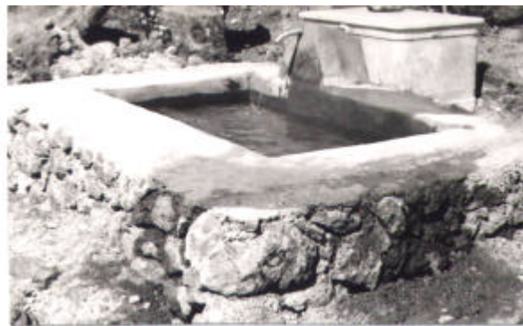
Fig. 4 - Vasca di raccolta dell'acqua dolce ottenuta per condensazione del vapore della favara. Veniva alimentata con circa un metro cubo di acqua al giorno e l'acqua era prelevata come acqua potabile dagli abitanti delle vicinanze ed usata anche per abbeverare il bestiame.
