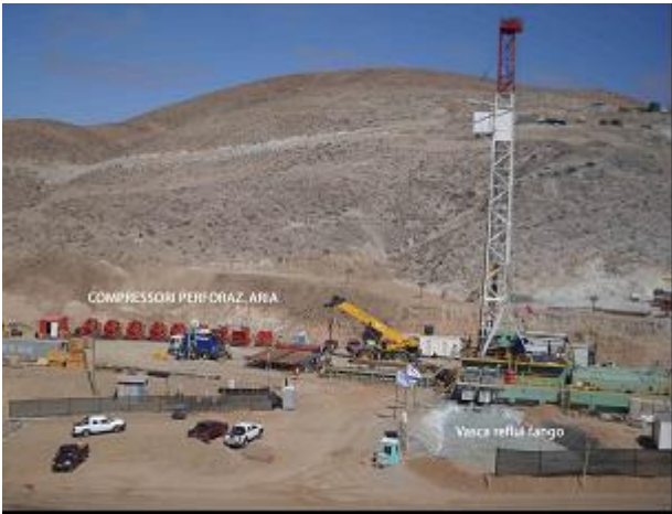
Fig. 6: Vista dell'impianto utilizzato per la perforazione del pozzo del "Plan C"
