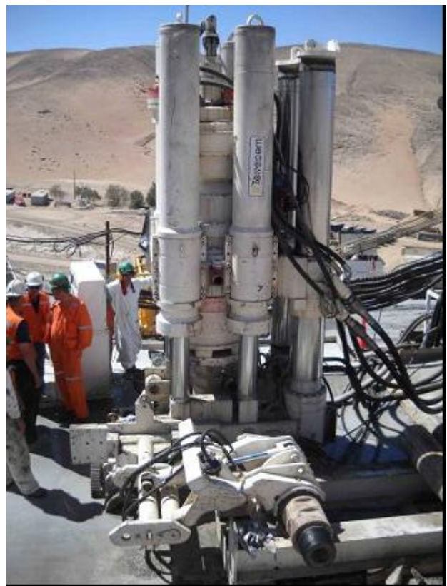
Fig.4: Vista dell'impianto usato per la perforazione del pozzo del "Plan A"
