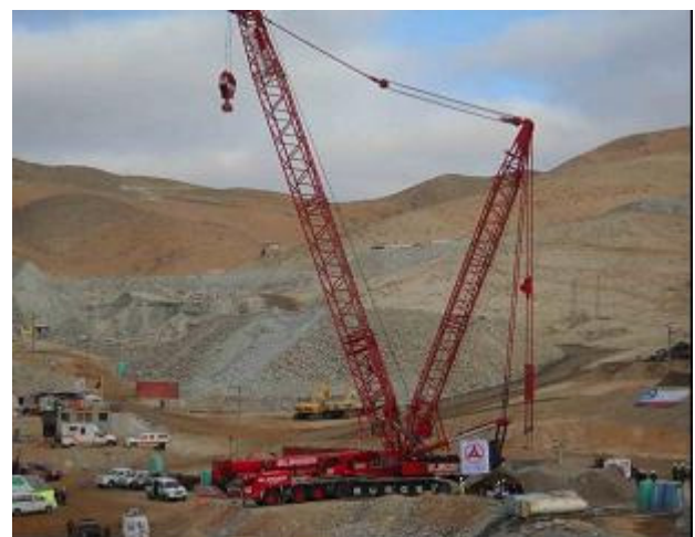
Fig. 9: Gru da 400 ton per il tubaggio del Pozzo "Plan B"
