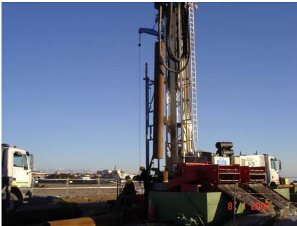
Fig. 3: Il pozzo Grado-1 in fase di rivestimento (a sinistra), e con la fuoriuscita spontanea, dal cavo delle aste, dell'acqua geotermica proveniente da 738 m di profondità (a destra).
