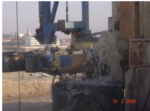
Fig. 3: Il pozzo Grado-1 in fase di rivestimento (a sinistra), e con la fuoriuscita spontanea, dal cavo delle aste, dell'acqua geotermica proveniente da 738 m di profondità (a destra).
