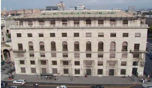
Fig.1: Edificio INPS a Genova oggetto dell'intervento
