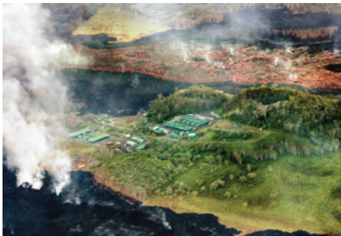
Fig.5: 3 giugno 2018, la lava fiancheggia l'impianto Puna Geothermal Venture
