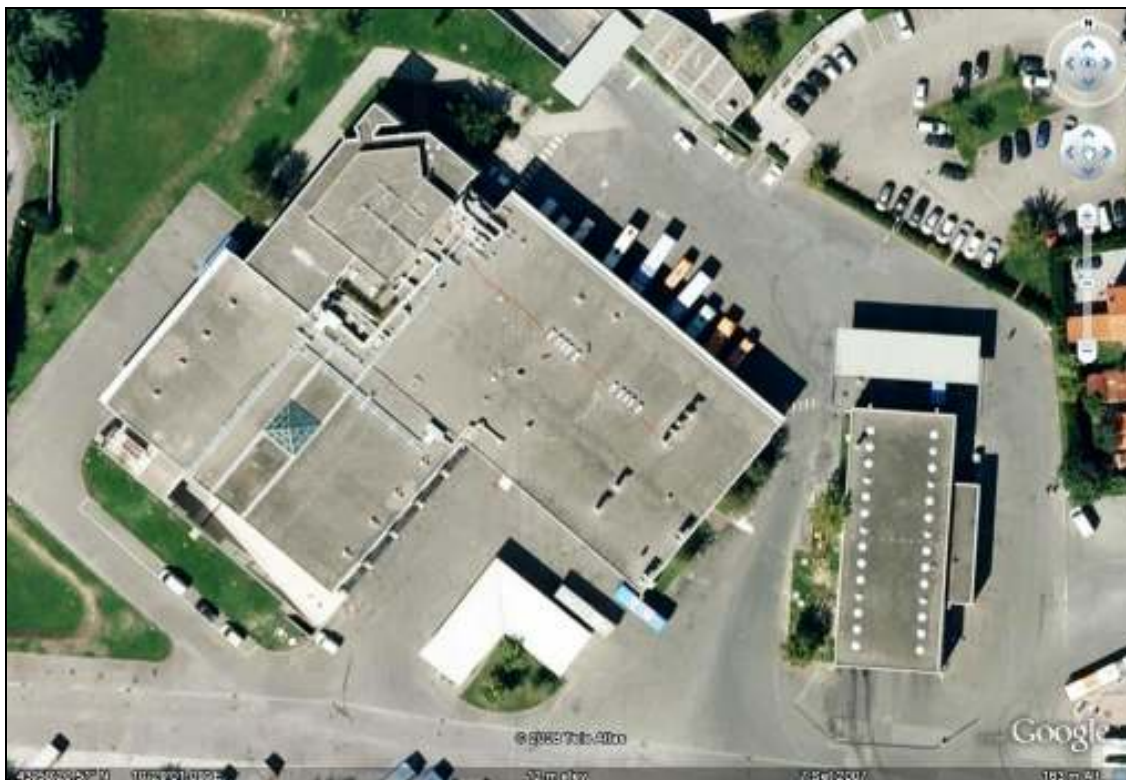
Fig. 11: foto della sede dell'Azienda dei Trasporti Clap Spa di Lucca, in cui è osservabile l'edificio principale e, in alto, il corpo distaccato, costituito dalla portineria ( http://www.googleearth.it ).
