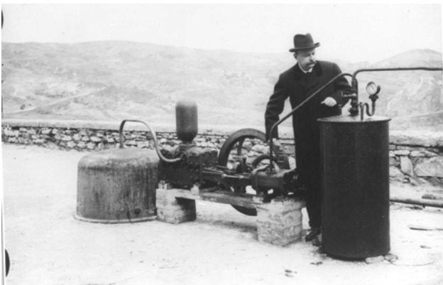
Il primo esperimento di produzione di energia elettrica con fluidi geotermici, effettuato a Larderello dal Principe Piero Ginori Conti nel 1904
